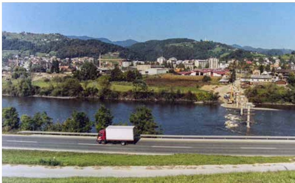
Gradnja betonske brvi preko reke Save v Sevnici. V ozadju novo sevniško naselje. Sevnica, 4. oktobra 1991.
