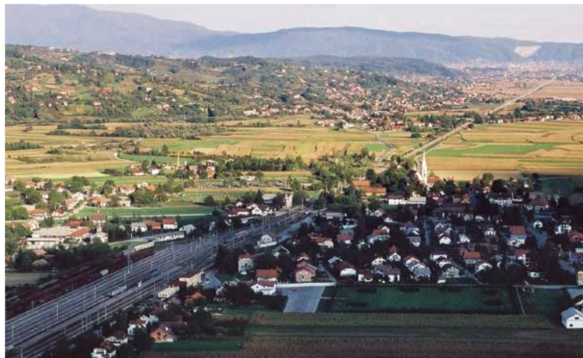
Železniško postajališče v Dobovi na železniški progi Ljubljana-Zagreb-Beograd. Leta 1991 pomemben vojaški objekt zaradi premika enot JLA.
