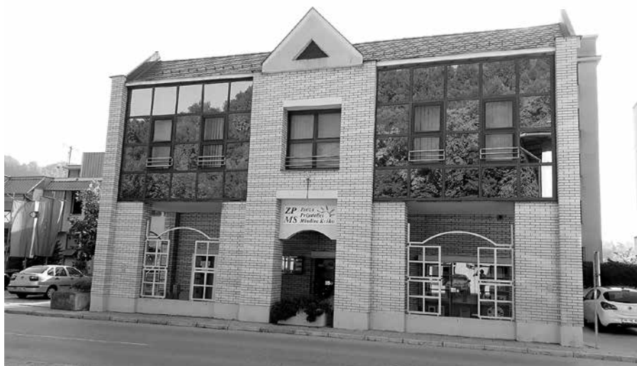
Nekdanja stavba Občinskega štaba TO občine Krško.
